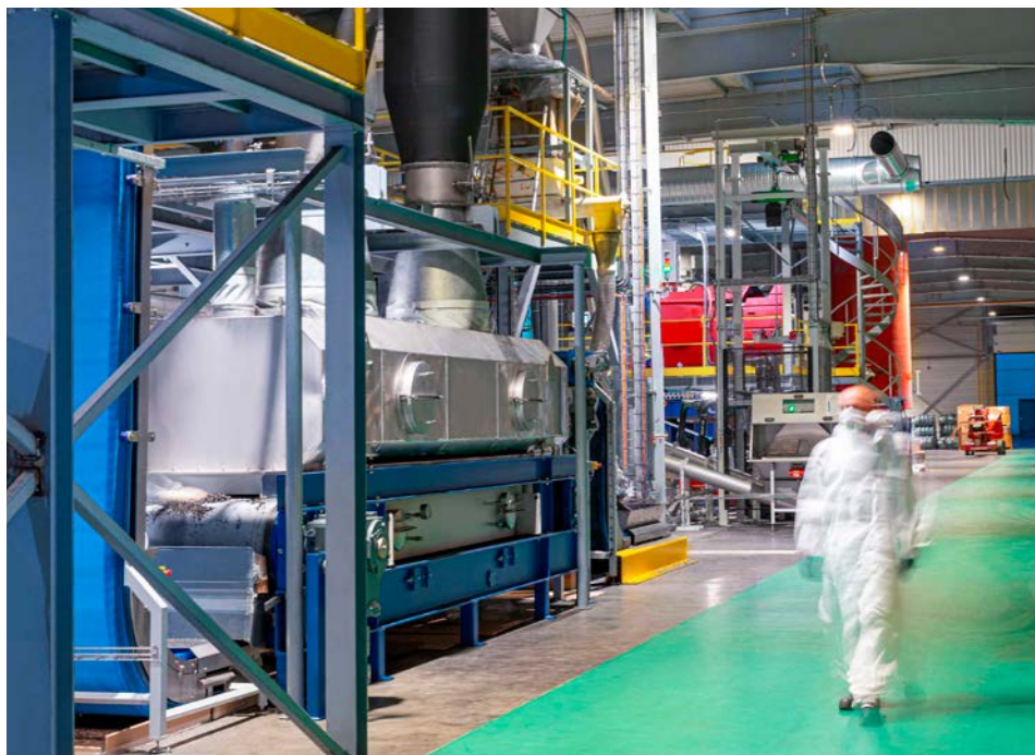
Les nouveaux locaux de Apply Carbon à Plouay s'étendent sur près de 16 000 m 2 .
